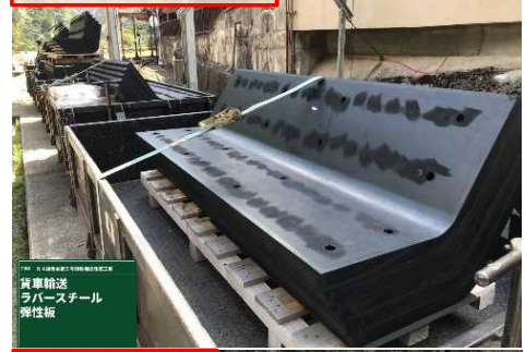
積卸状況:車両
