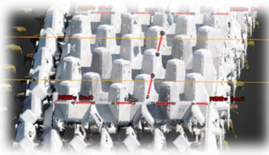
【3次元点群データによる出来形確認】
