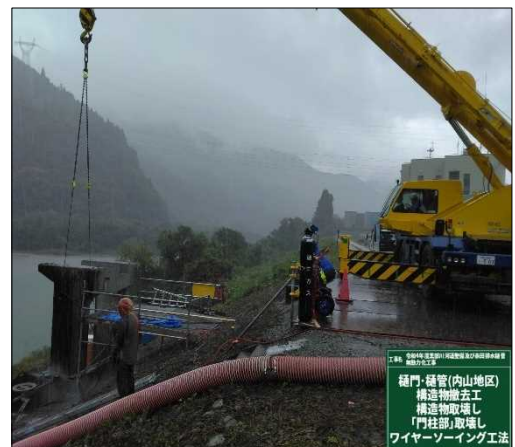
写真6 「ブロック分割」による取壊し状況
