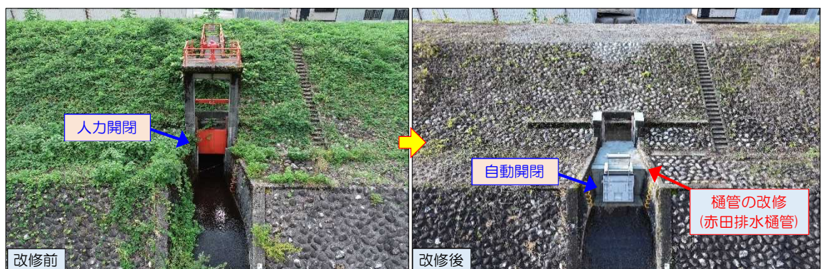
写真 3 ③内山地区 (L13.6k 付近)
