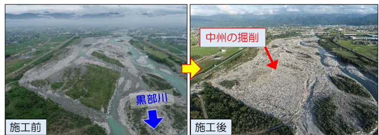
写真 1 ①若栗新地区 (5.6k 付近)
