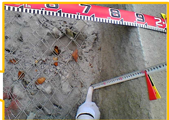
写真 10.段階確認（吹付枠確認）
