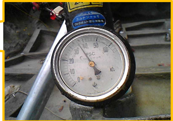
写真 8.下請検査（緊張確認試験）
