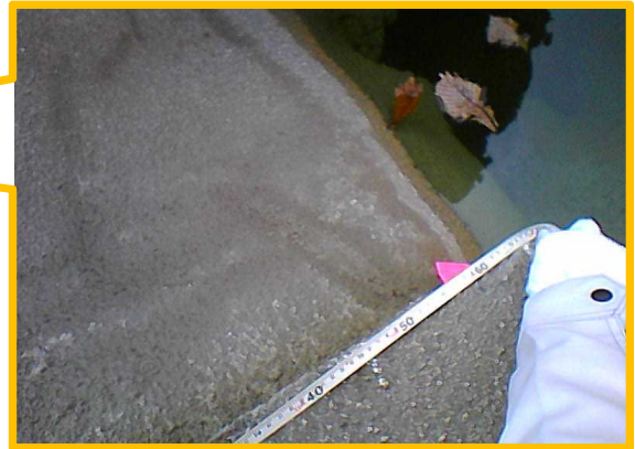
写真 6.社内検査（法枠延長検査）
