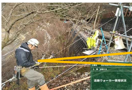
写真 4.法面ウォーカー使用状況
