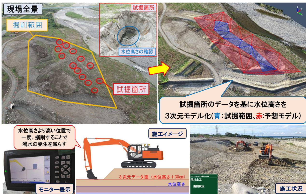
図8 掘削時における3次元データとICT建機を活用した水位高さの「見える化」
