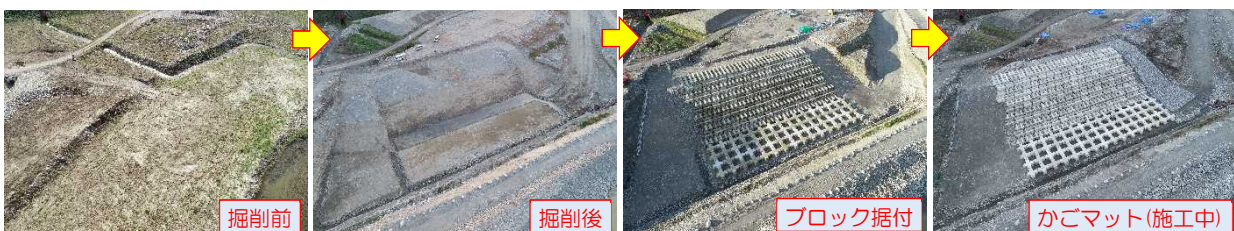
写真3 各施工段階での状況写真(ドローンによる定点撮影 <同じ位置・高度・カメラアングル>)
