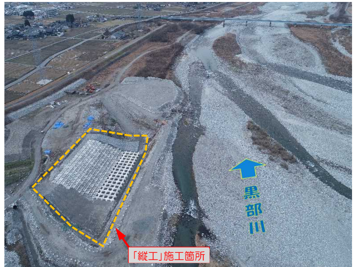
写真1 黒部河川内での急流河川対策工事(施工中)
