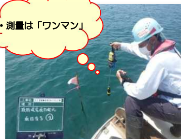
【 ICT 施工現場端末を使用した測量業務 】
