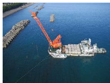
【起重機船作業】
