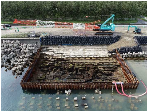
被災状況（鋼矢板設置完了時撮影）
