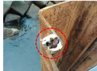
パイルロックの吸水膨張後
