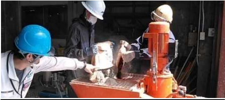
写真① 試験施工の実施
