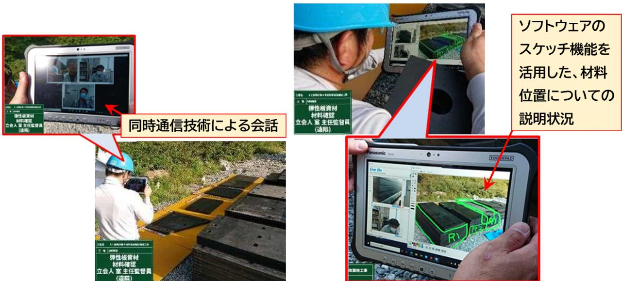
写真7. 遠隔臨場による材料確認状況(受発注者間)
