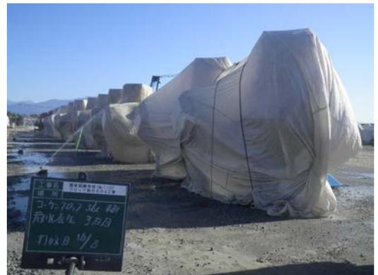
時間制御式散水システム
