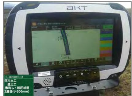
ICT 施工により曲線形状部を各層ごとに切替えて敷均し、GNSS 締固め回数管理にて転圧管理(測量なし)
