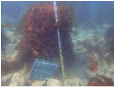
突出した異形ブロック脚部
