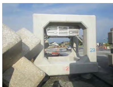
根固ブロック(18t)ステンレス漁礁取り付け状況
