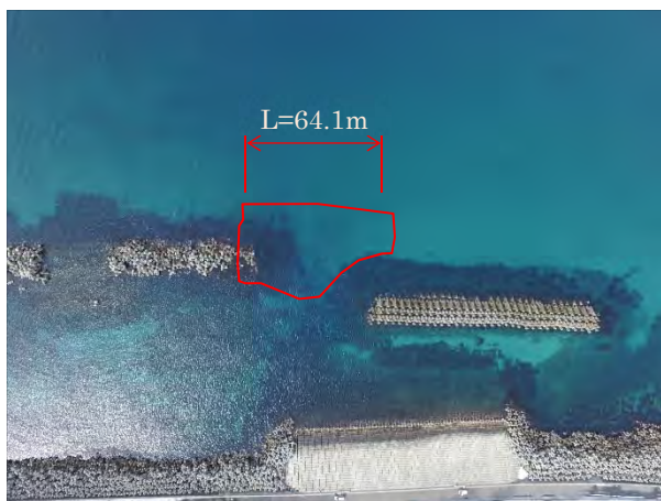
園家離岸堤(No106)着工前写真
