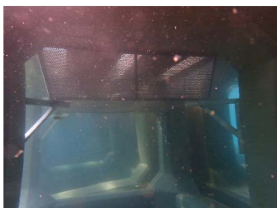
水中部据付状況
