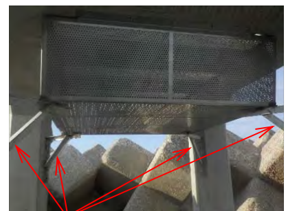
脱落防止用ブラケット取り付け N=4 箇所
