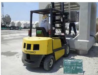
根固ブロック(18t)ステンレス漁礁取り付け状況
