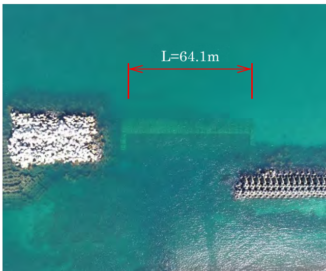
園家離岸堤(No106)完成写真
