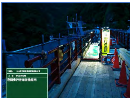
夜間開放時仮橋・照明
