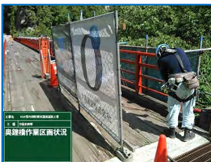
区画フェンス
