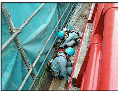
隙間養生状況
