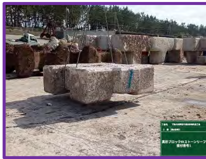
写真 4-2 異形ブロック(根固め)
