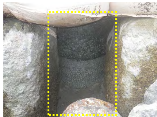
写真 4-7 水中コンクリート打設後 裏側より
