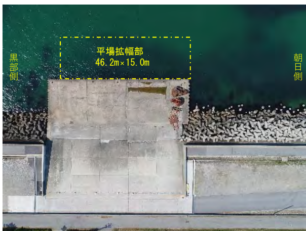
写真 6-1 着手前(平成 30 年 4 月)
