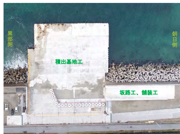
写真 6-2 進捗写真(平成 31 年 1 月)
