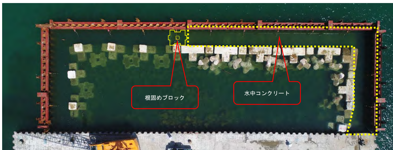
写真 4-8 第1回水中コンクリート打設完了 ※図 3-4 施工ステップ(2)参照
