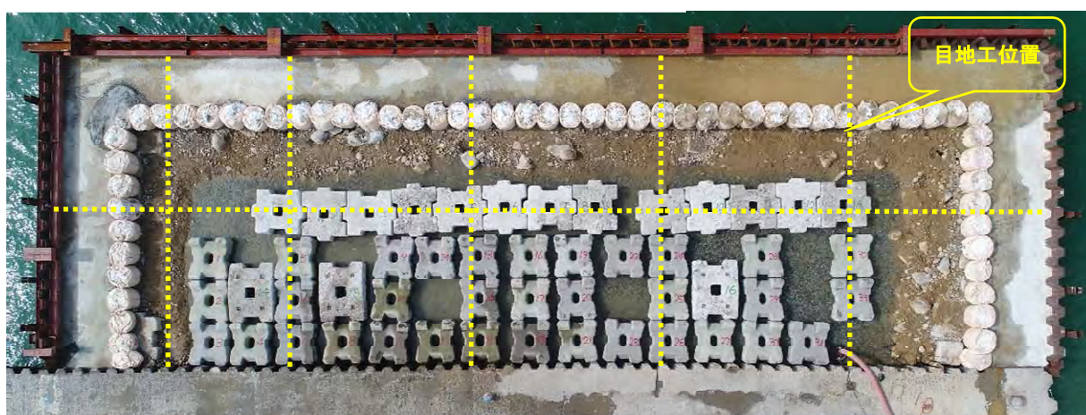
写真 4-9 異形ブロック(根固め)据付完了 ※図 3-6 施工ステップ(4)参照
