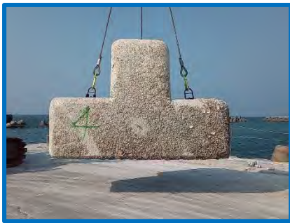
写真 4-1 異形ブロック(六脚正吊)
