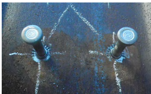
写真 4-11 スタッドジベル接写
