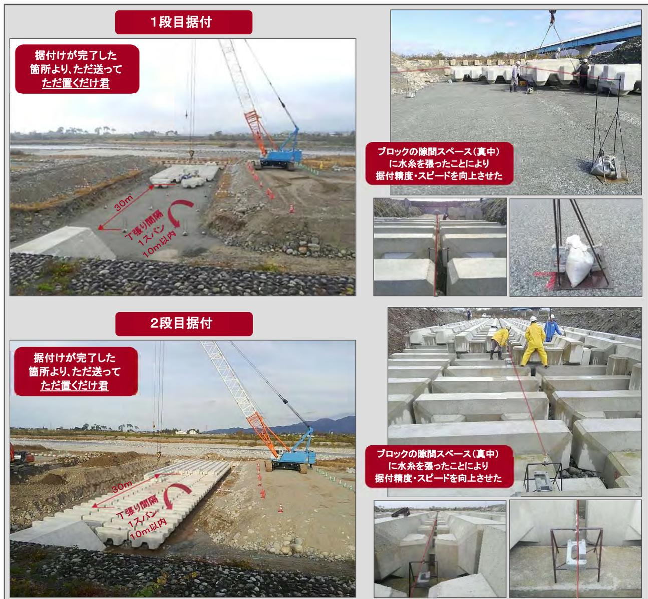
【ただ置だけ君】により丁張り設置の作業効率は大幅に向上した。30m/3列3スパンの丁張り設置を現場員2人で行った場合に1段目は1.5h、2段目は1.0hとなる。十分据付最中に丁張り設置は可能であり、余裕を持って据付管理も遂行できた。同条件での杭丁張りと比較してみると1段目は2.5倍、2段目は3倍の軽減効果が得られた。ラップ工程の据付を予定通り11月30日で完了した。
