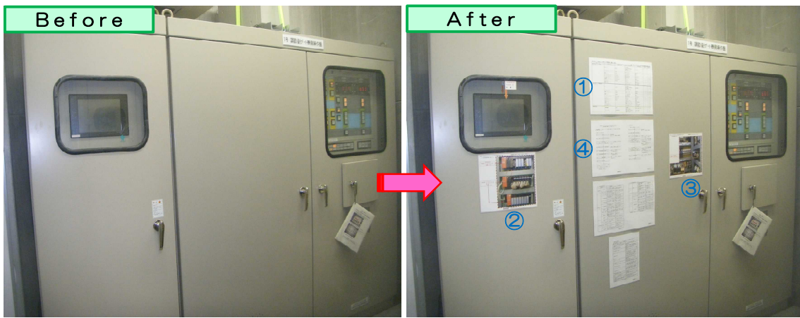
【写真2 取替部品箇所案内板、取替部品一覧表、総合試運転手順書設置状況】
