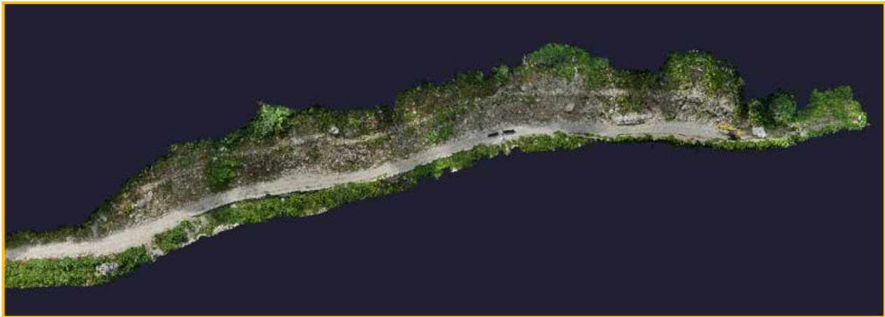
法面吹付箇所起工測量写真
