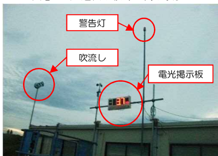
図①-1 風速表示板等の掲示状況
