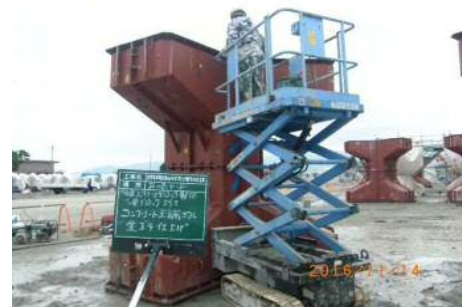
図③-1 高所作業車による天端均し状況
