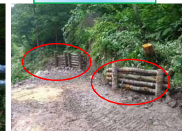
支障木利用丸太柵
