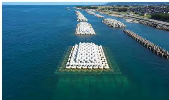
吉原副離岸堤 (No142) その1工事完成
