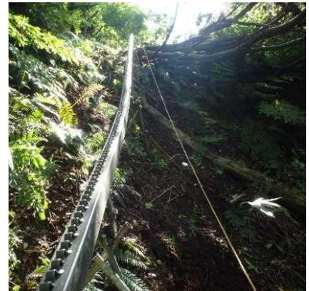
写真-5 通勤路手摺りロープ設置
