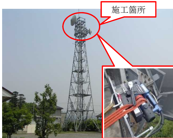
【写真3 省力化機械工具設置状況】
