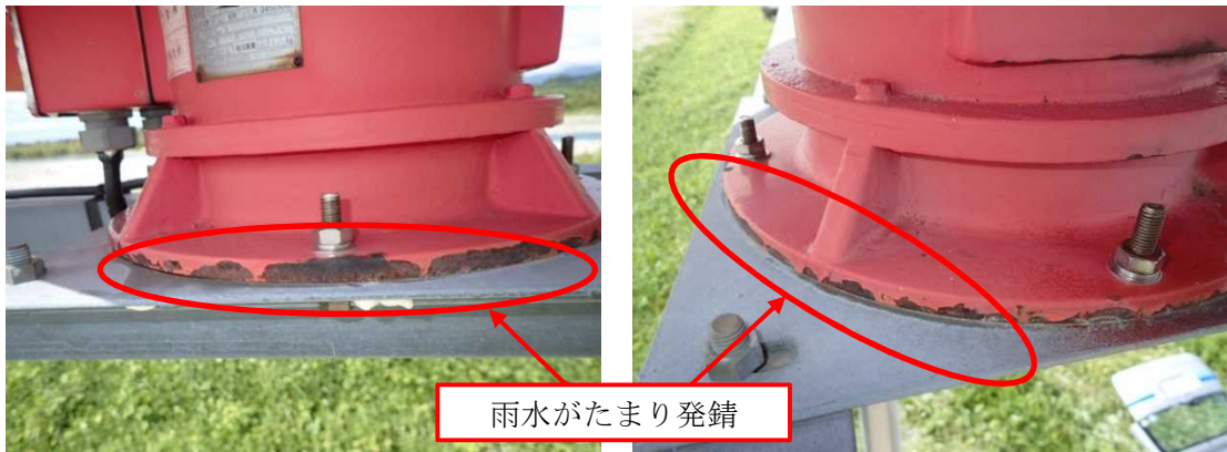
【写真6 既設サイレン取付状況】
