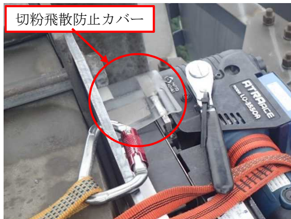
【写真5 切粉飛散防止カバー・布袋使用状況】
