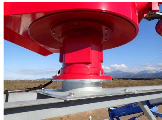
【写真8 新設サイレン取付状況】
