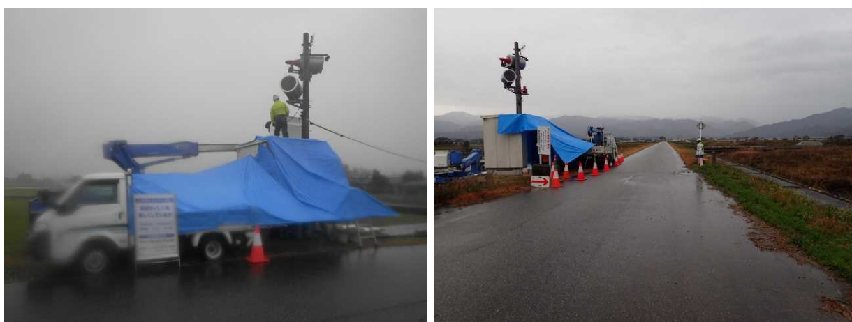
【写真1 屋根設置状況】
