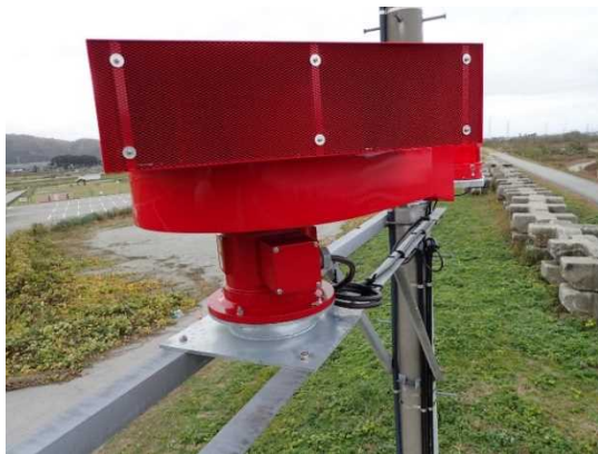
【写真8 新設サイレン取付状況】
