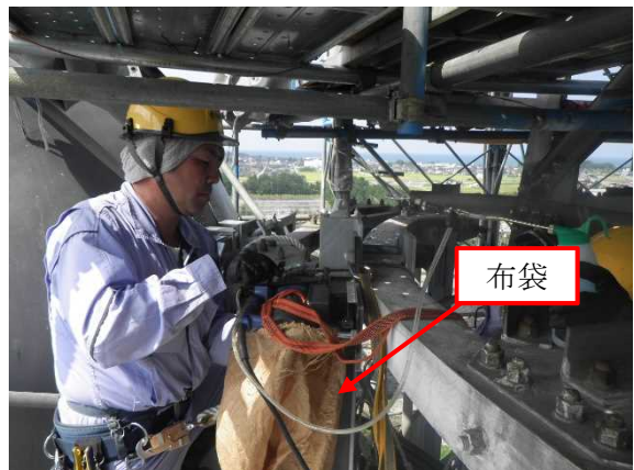
【写真5 切粉飛散防止カバー・布袋使用状況】
