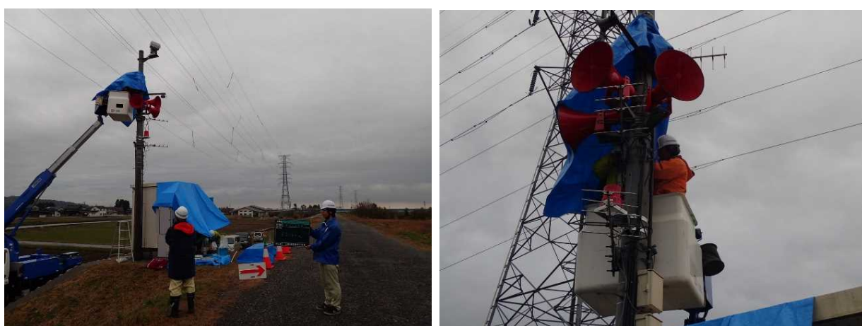
【写真2 屋外接続作業状況】
