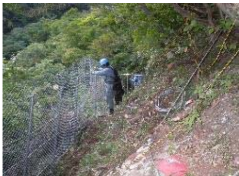
写真-4 仮設落石防護柵設置状況
