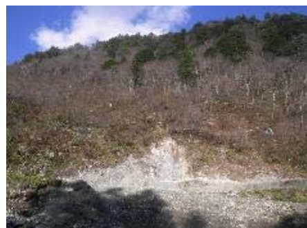
写真-1 本体施工箇所右岸山腹 （全景）H27.11.30撮影
