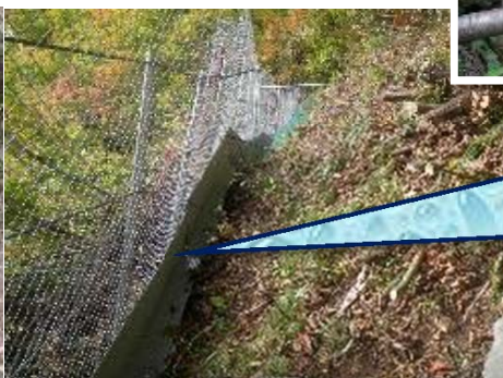
写真-5 設置完了（感音板設置）
