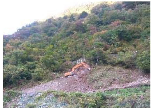
写真-6 本体掘削施工状況 (落石対策完了後)
