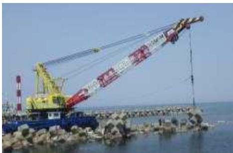
20tブロック撤去状況
