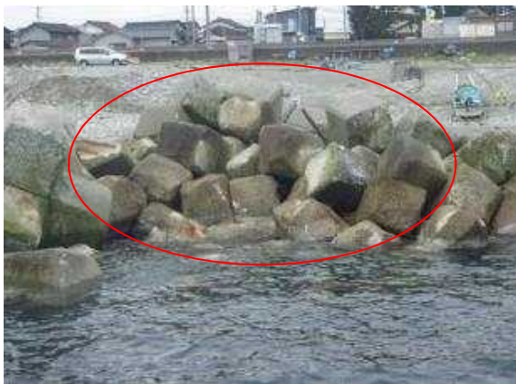
撤去箇所写真(陸上)
