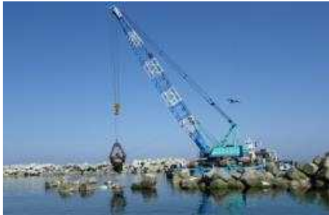
クラムバケットによる撤去状況
