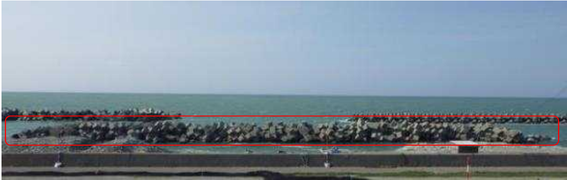
撤去箇所全景
