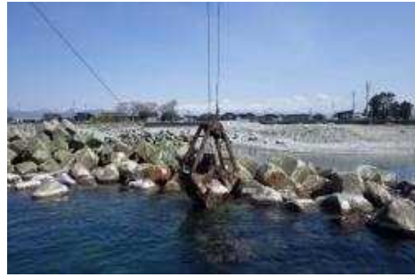
クラムバケットによる撤去状況
