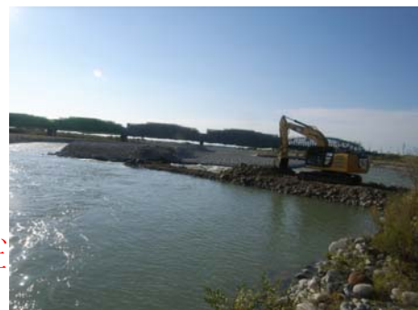
写真5-1-2 仮締切盛土状況
