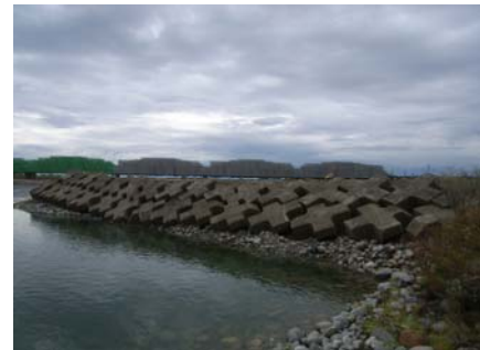
写真5-2-2 仮締切補強
