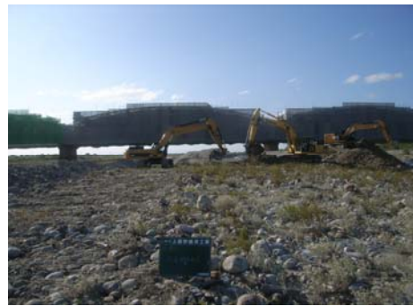
写真5-1-1-2 河道掘削状況
