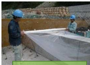
写真-5 ビニールフィルム 設置状況
