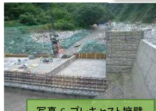
写真-6 プレキャスト擁壁 設置完了(全景)
