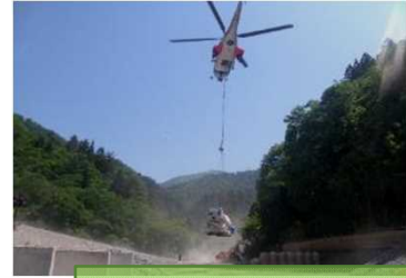
写真-1ヘリコプターによる輸送 (トラックミキサーの車体)
