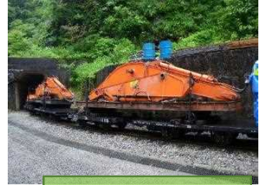
写真-2 機材の鉄道輸送 (バックホウ0.8m 3 級・ブーム)
