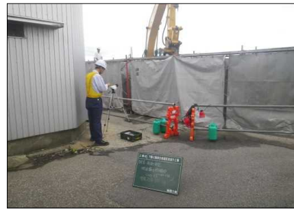
騒音・振動測定状況(写真-9)
