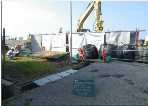
設置状況(写真-7)
