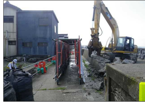
設置状況(写真-8)
