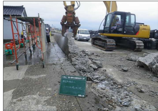
クラッシャーによる取壊し状況(写真-2)
