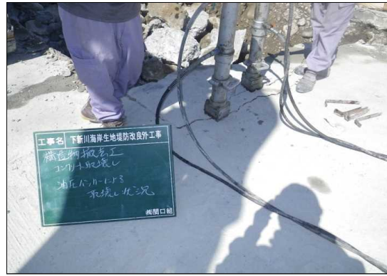
油圧パッカーによる取壊し状況②(写真-4)
