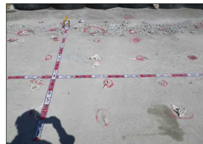
削孔全景(写真-6)
