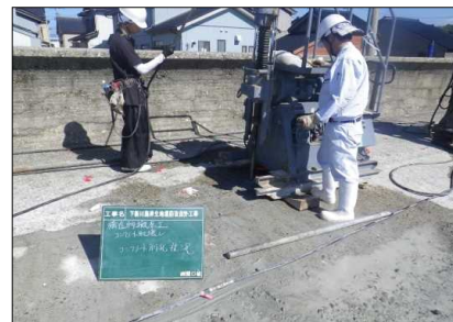
ボーリング削孔(写真-5)
