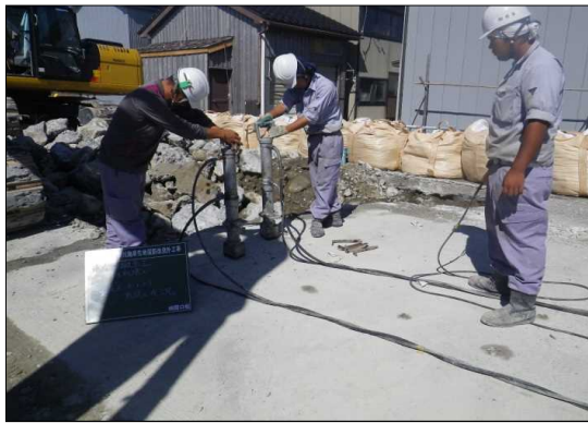
油圧パッカーによる取壊し状況①(写真-3)
