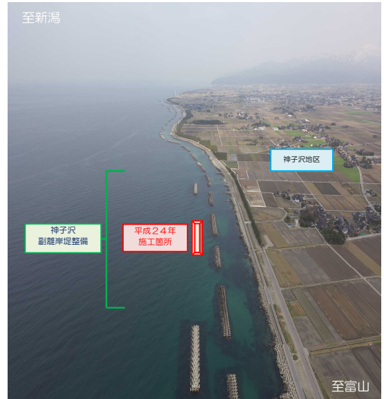
【下新川海岸(神子沢沖合)の副離岸堤整備】
