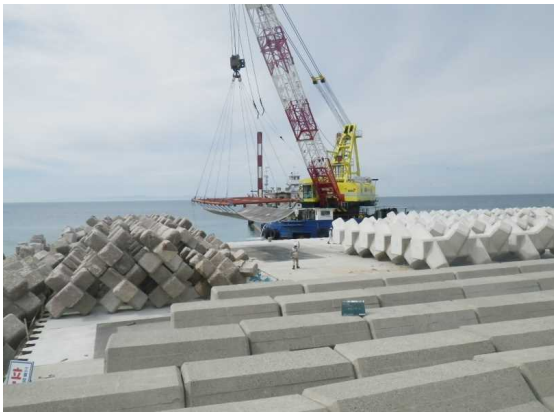
【 アスファルトマット海上運搬積込 】
