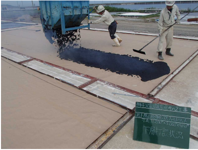
【下層 AS 合材打設】
