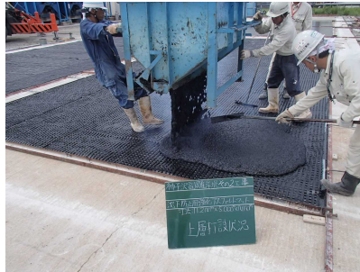
【上層 AS 合材打設】
