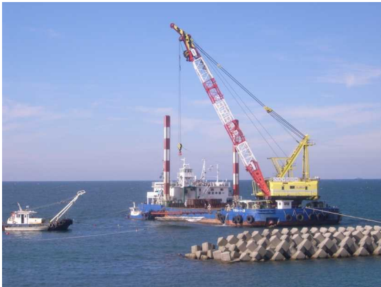
【 アスファルトマット海上運搬設置 】
