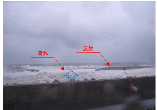
【浅海域における波浪変形の諸要素 流れ、反射状況】
