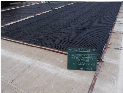
【補強材 ガラス繊維テープ網設置】
