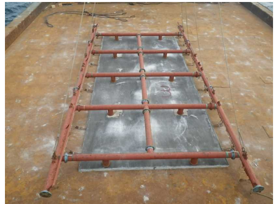
【 アスファルトマット海上運搬積込完了 】
