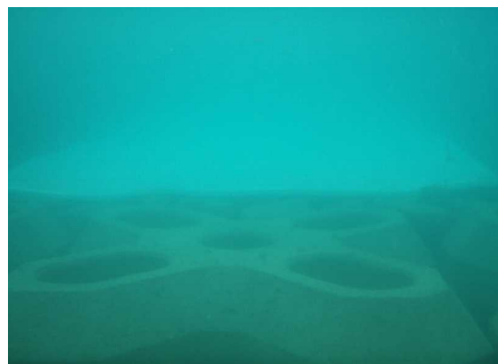
【 No.4+16.54 西側堤体マウンド設置完了 】
