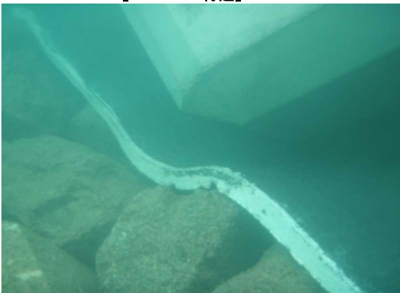
【台風 26 号高波波浪後 副離岸堤側面部アスファルトマット設置状況並びに捨石現況】 【NO.0+7.52 付近】
