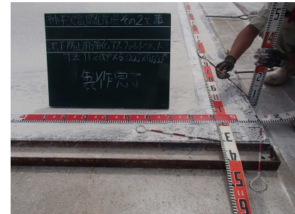
【アスファルトマット出来形測定】
