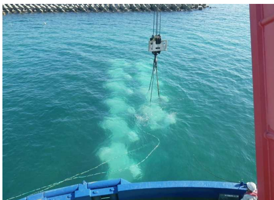
【 海域堤本体工 海岸コンクリートブロック No.0+2.52 付近 異形ブロック据付 】
