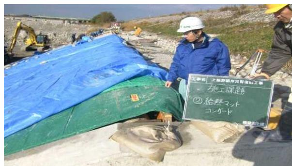
マットは従来の養生マットとくらべ、保水量が約10倍以上、保水時間が5倍以上あるため、養生開始時に湿潤状態にすることで、給熱養生による急激な乾燥を防ぎ湿潤状態(コンクリート表面相対湿度80%以上)を保つことが出来る。
