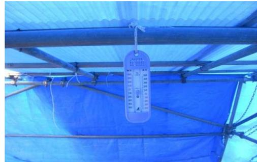
②練石張り施工当日は、雪寒仮囲い内をジェットヒーター(熱出力43kw)で給熱養生するが、翌日以降雪寒仮囲いを取外し、湿潤目的のQマット(NETIS:No.KT-980368-A)と給熱マット(電熱式)を併用して行うことで、均一な養生(5℃を12日間+2日間)を行うことが出来ると共に、雪寒仮囲いの数を少なくすることが出来る。
