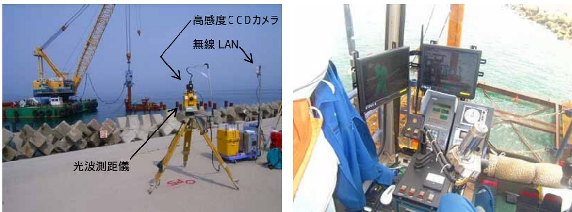
写真 2-2 高感度 C C D カメラを使用した鋼管杭の鉛直精度管理
