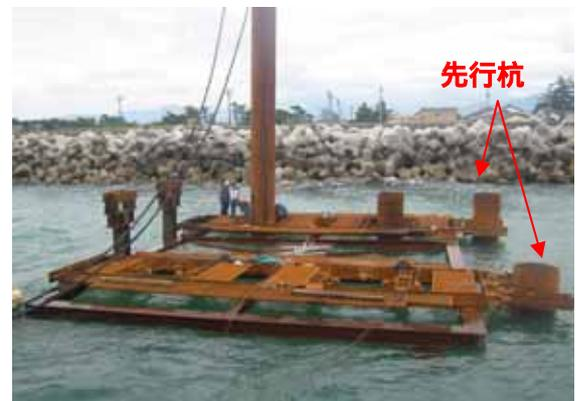
写真2-1 導枠使用状況
