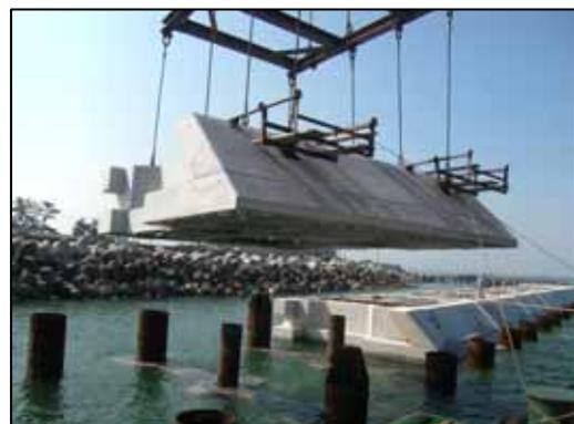
写真3-2 据付ガイドを使用した堤体据付
