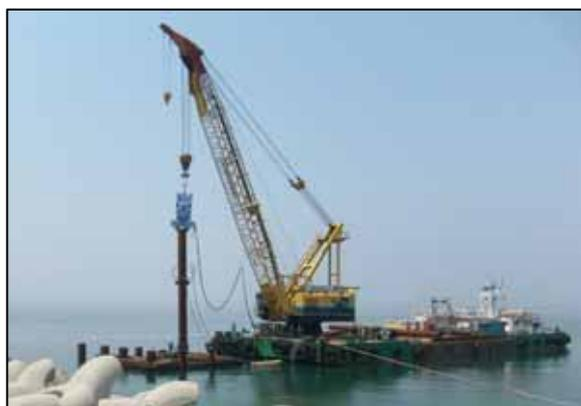
写真 2-3 電動式可変モーメント型大型パイプロハンマによる鋼管杭打設
