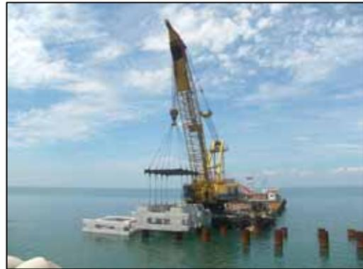
写真3-1 吊枠を使用した堤体ブロック運搬および据付状況
