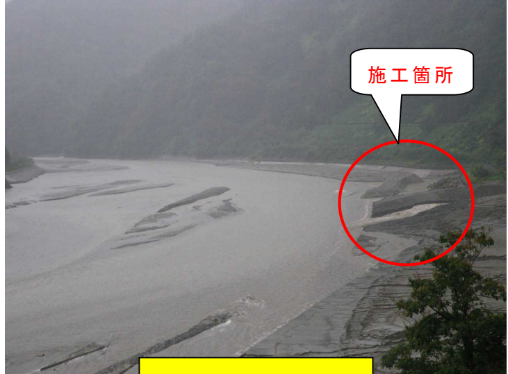
H23.9.30 出水状況
