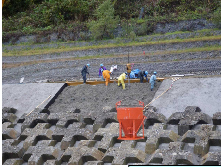
平張コンクリート打設状況
