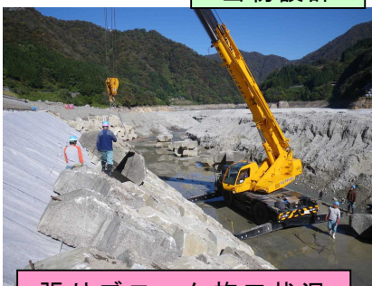
張りブロック施工状況
