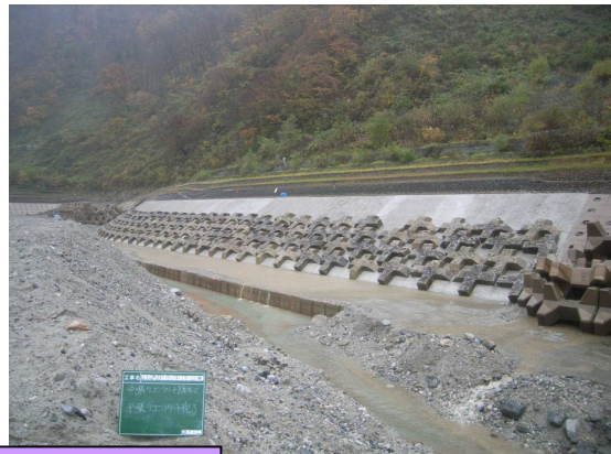
平張コンクリート施工完了
