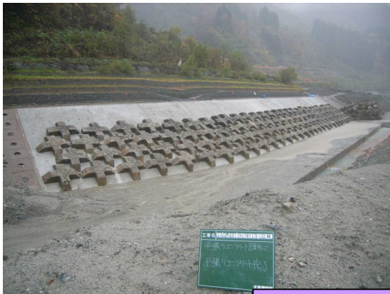
平張コンクリート施工完了
