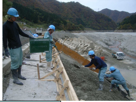
平張コンクリート打設状況
