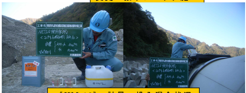
《KM-10》 計量・投入混合状況
