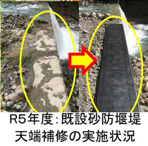
R5年度: 既設砂防堰堤天端補修の実施状況
