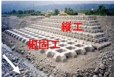
高水敷幅が狭く洗掘による河床低下に伴い護岸基礎等の浮き上がりが発生している、若しくは発生する恐れのある箇所では、根継ぎ護岸による対策を実施。
