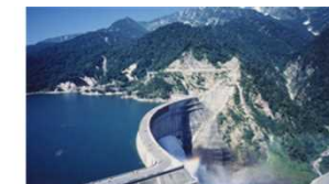
黒部ダム(S38完成) 関西電力(株)の発電専用ダム
