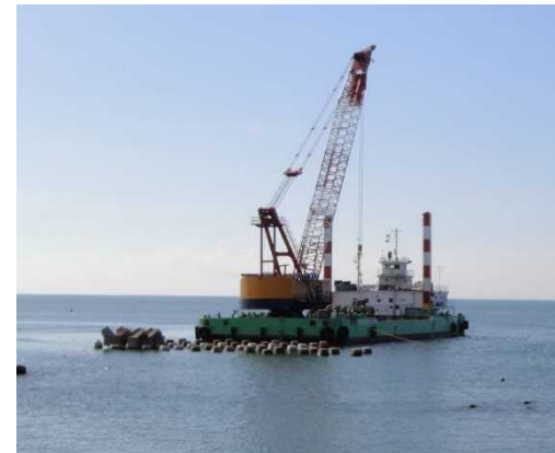
副離岸堤施工状況(本体ブロック据付)
