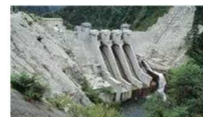
出し平ダム(S60完成) 関西電力(株)の発電専用ダム
