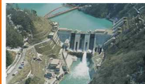
宇奈月ダム(H12完成) 国土交通省管理ダム
