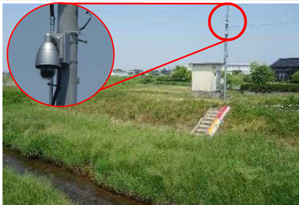
河川監視カメラ設置状況
