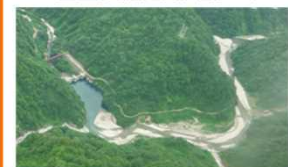
小屋平ダム(S11完成) 関西電力(株)の発電専用ダム
