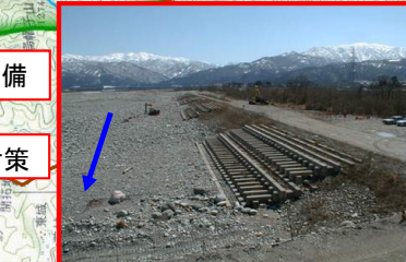
急流河川対策(縦工)
