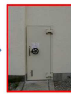
出入口扉の水密化
