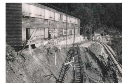
寸断された黒部峡谷鉄道
