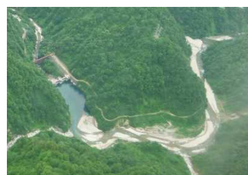
小室平ダム(S11完成) 関西電力(株)の発電専用ダム
