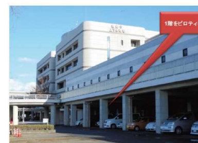
水道局の耐水化事例(局舎嵩上げ)
