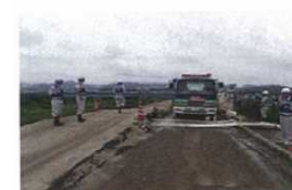
【ホースブリッジ完成】 排水ホース上を車両が通行するための対策例 (ホースブリッジ) (H26年8月豪雨(中国地整))
