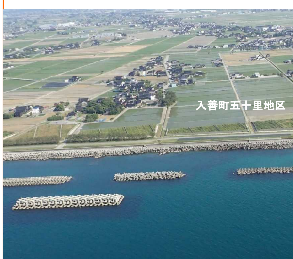
入善町五十里地区の離岸堤設置状況
