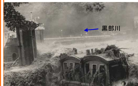
増水時の愛本堰堤
