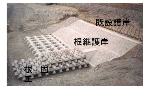
護岸(根継護岸工)の状況
