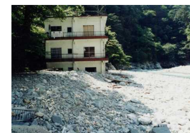
土砂流出により埋没した猿飛山荘
