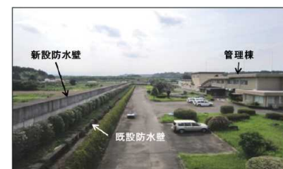
浄水場の耐水化事例(全周防水壁)
