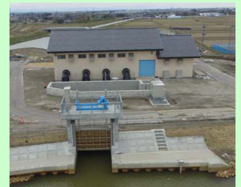
排水機場全景
