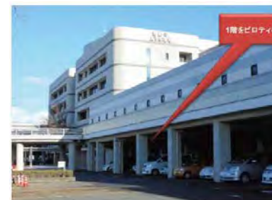
水道局の耐水化事例(局舎嵩上げ)
