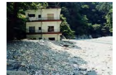
土砂流出により埋没した猿飛山荘
