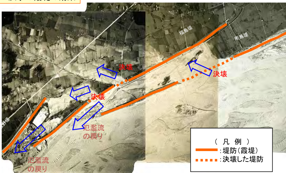
南島、福島堤の決壊状況（昭和44年8月洪水）
