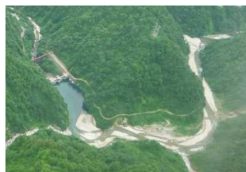
小屋平ダム(S11完成) 関西電力(株)の発電専用ダム
