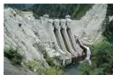
出し平ダム(S60完成) 関西電力(株)の発電専用ダム
