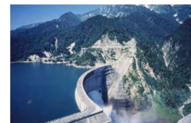
黒部ダム(S38完成) 関西電力(株)の発電専用ダム
