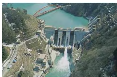
宇奈月ダム(H12完成) 国土交通省管理ダム
