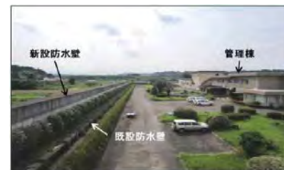
浄水場の耐水化事例(全周防水壁)
