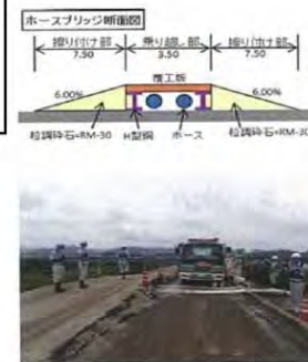
排水ホース上を車両が通行するための対策例(ホースブリッジ) (H26年8月豪雨(中国地整))
