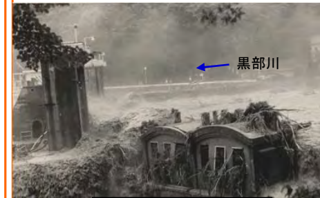
増水時の愛本堰堤
