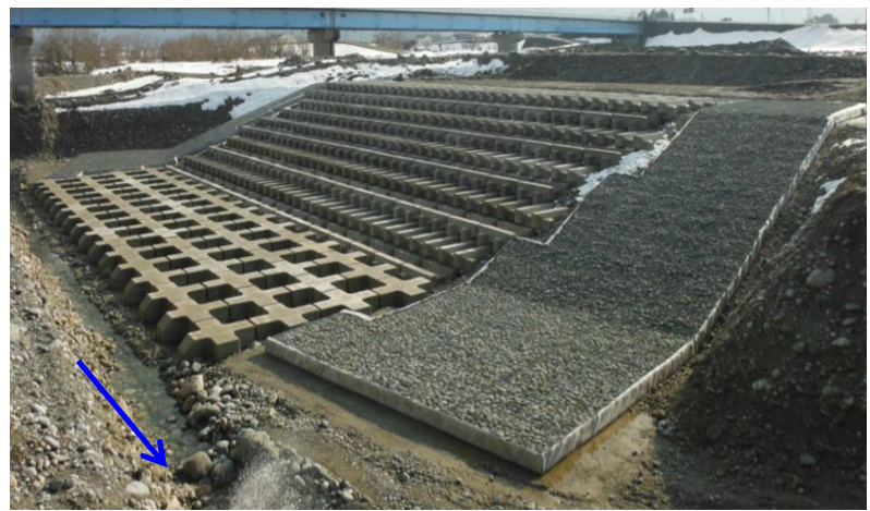
縦工既施工状況
