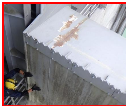
R7補正修繕予定 越流部洪水吐設備1号・2号ゲート 塗替塗装
