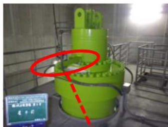
R08修繕予定 排砂設備 1号・2号調節ゲート リミットスイッチシリンダー取替
