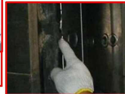
R07補正修繕予定 排砂設備 2号調節ゲート 水密ゴム交換
