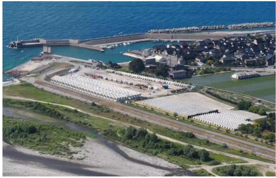
離岸堤ブロック製作状況(芦崎ブロックヤード)
