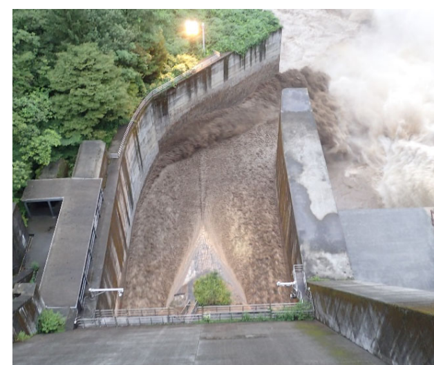
排砂ゲート開操作30分後 【8月21日5時40分】
