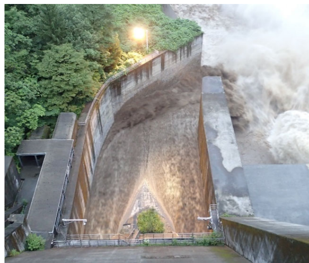
排砂ゲート開操作20分後 【8月21日5時30分】
