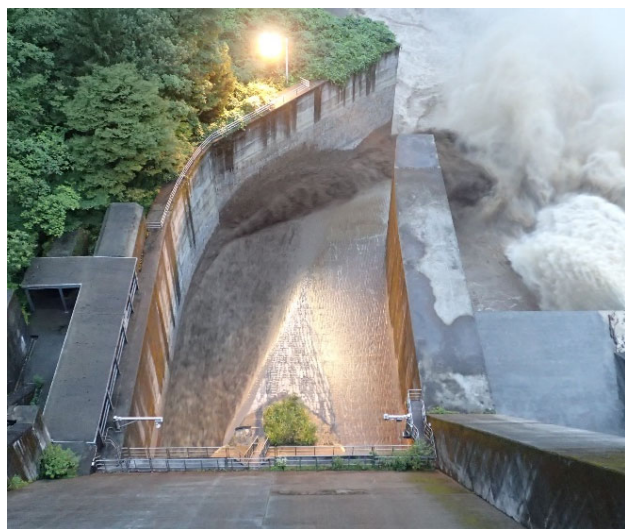
排砂ゲート開操作10分後 【8月21日5時20分】
