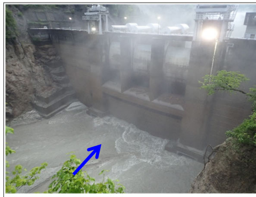
【出し平ダム排砂路呑口部】自然流下開始時(EL.305.10m) 7月6日 4:50撮影
