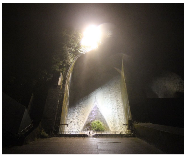
排砂ゲート開操作30分後 【7月5日20時00分】
