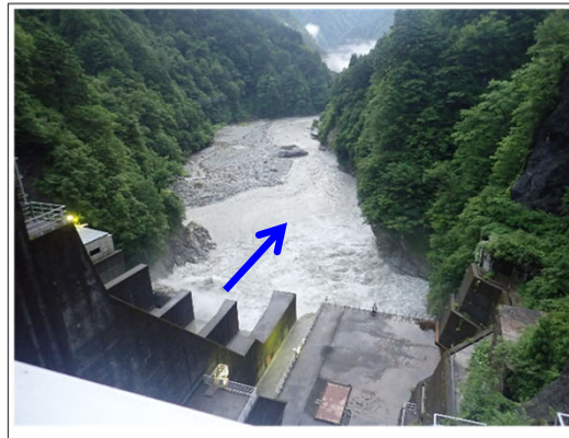
【出し平ダム下流】自然流下開始時(EL.305.10m) 7月6日 4:50撮影
