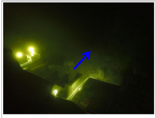
【出し平ダム下流】水位低下中(EL.316.08m) 7月6日 1:30撮影
