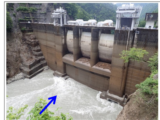
【出し平ダム排砂路呑口部】自然流下完了(EL.305.06m) 7月6日 13:00撮影
