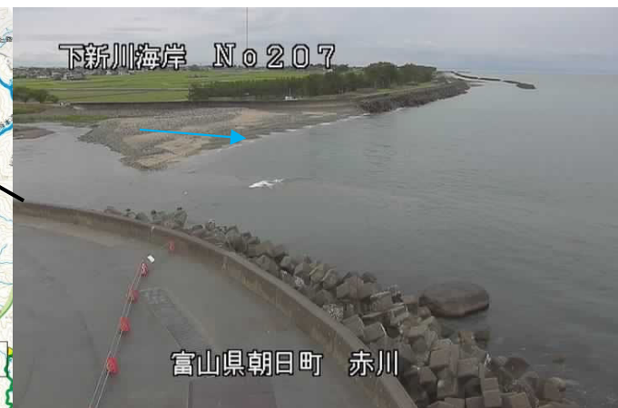
下新川海岸 No.207 富山県朝日町 赤川 小川 (7月6日 6:00 CCTV画像)
