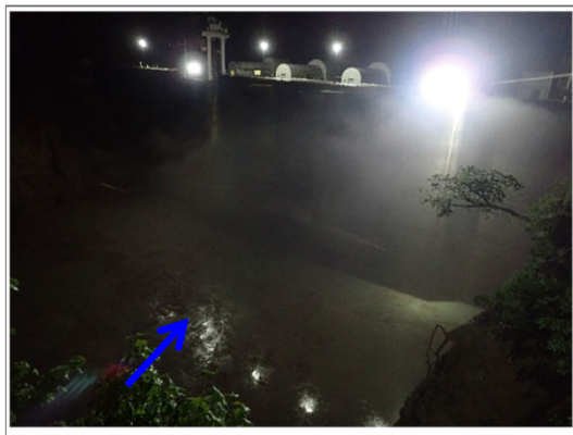
【出し平ダム排砂路呑口部】水位低下中(EL.316.08m) 7月6日 1:30撮影
