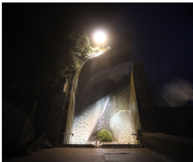
排砂ゲート開操作10分後 【7月5日19時40分】
