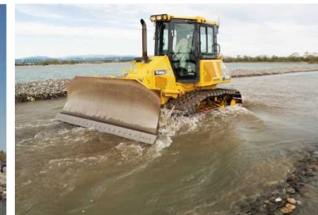
礫投入、礫の汚れ剥ぎ
