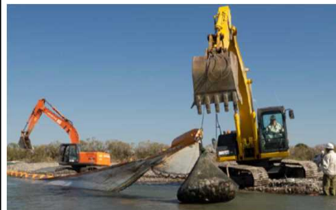
掘削前の防護膜の設置
