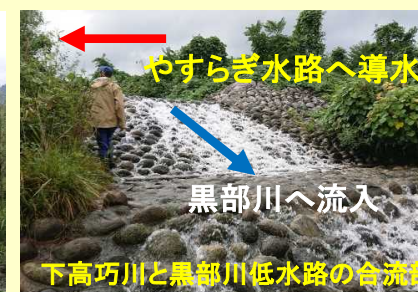
合流支川(下高巧川)の河川水 をやすらぎ水路へ導水
