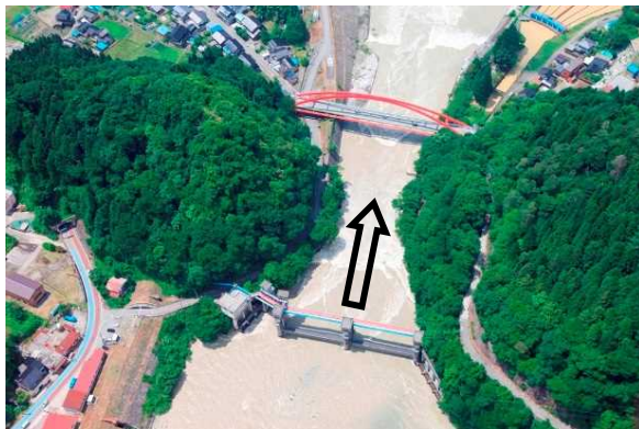
愛本合口堰堤（河口より13.5km）
