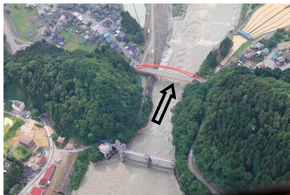
愛本合口堰堤（河口より13.5km）
