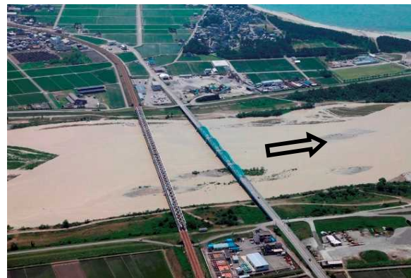
下黒部橋（河口より0.8km）
