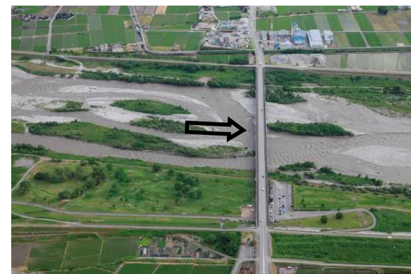
権蔵橋（河口より8.2km）
