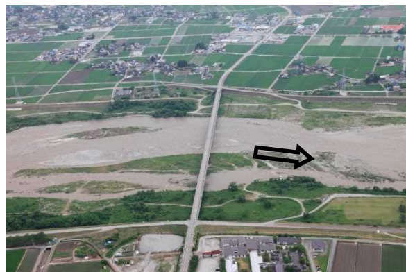
新川黒部橋（河口より9.6km）
