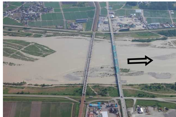
下黒部橋（河口より0.8km）
