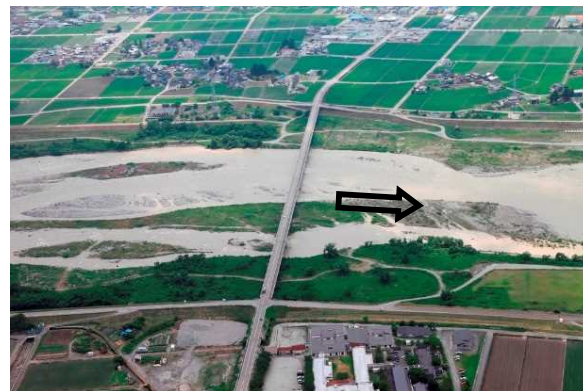
新川黒部橋（河口より9.6km）
