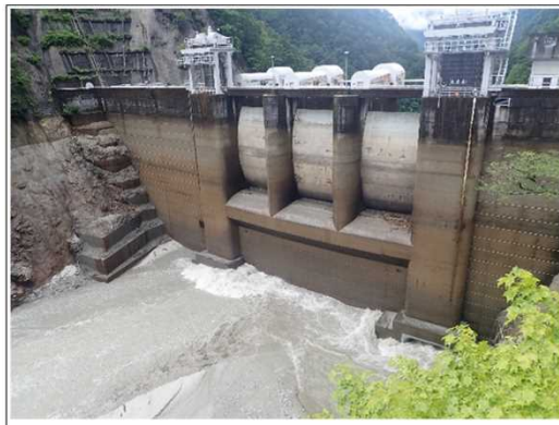
【出し平ダム排砂路呑口部】自然流下開始時(EL.305.16m) 7月29日 14:30撮影
