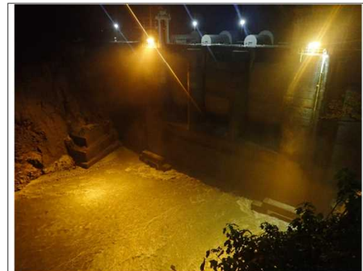
【出し平ダム排砂路呑口部】自然流下完了(EL.305.06m) 7月29日 22:20撮影
