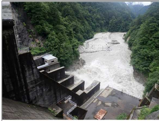
【出し平ダム下流】自然流下開始時(EL.305.16m) 7月29日 14:30撮影
