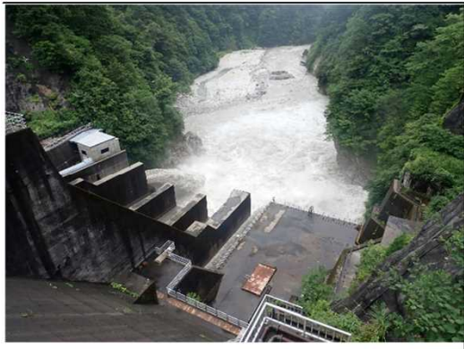
【出し平ダム下流】水位低下中(EL.316.00m) 7月29日 12:10撮影
