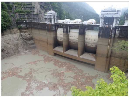
【出し平ダム排砂路呑口部】水位低下中(EL.316.00m) 7月29日 12:10撮影
