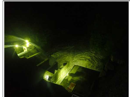
【出し平ダム下流】自然流下完了(EL.305.06m) 7月29日 22:20撮影
