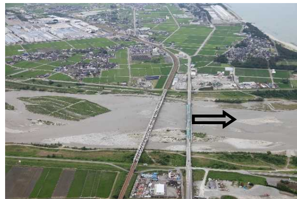
下黒部橋（河口より0.8km）
