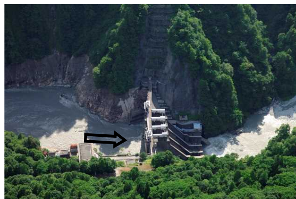
出し平ダム(右岸より望む)
