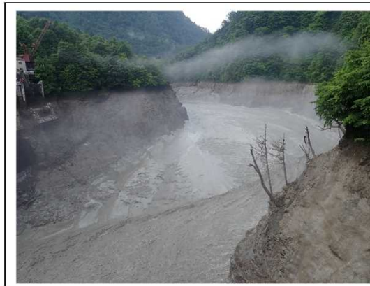
【出し平ダム湛水池】自然流下開始時(EL.306.72m) 6月27日 6:34撮影
