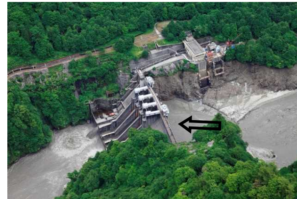
出し平ダム(左岸より望む)
