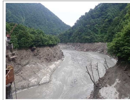
【出し平ダム湛水池】自然流下完了(EL.303.92m) 6月27日 14:20撮影
