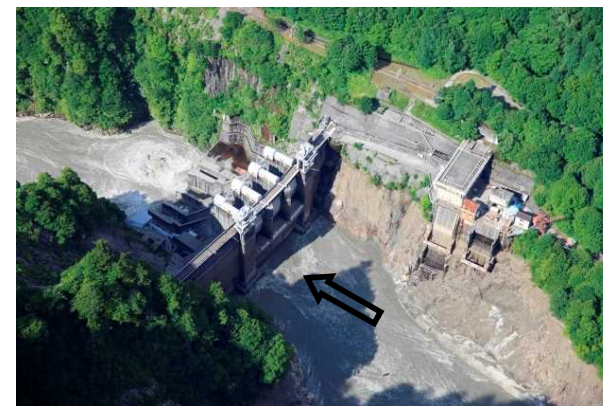
出し平ダム(左岸より望む)
