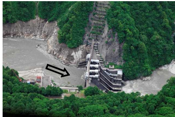
出し平ダム(右岸より望む)
