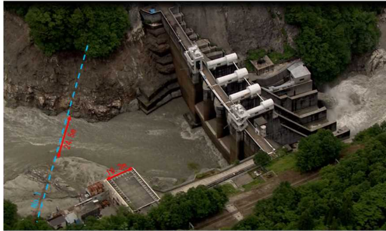
図-5 出し平ダム堤体付近ヘリ画像 (6/17 13:00頃撮影)
