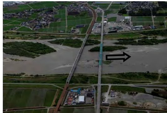
下黒部橋（河口より0.8km）
