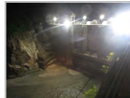
【出し平ダム排砂路呑み口部】自然流下完了(EL.305.23m) 6月17日 20:04撮影
