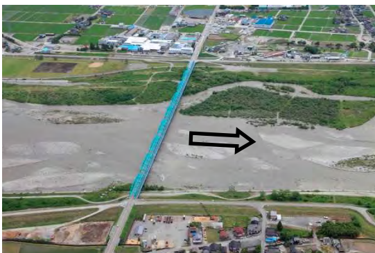
黒部大橋(国道8号)（河口より4.8km）
