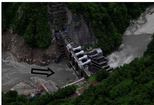
出し平ダム（右岸より望む）
