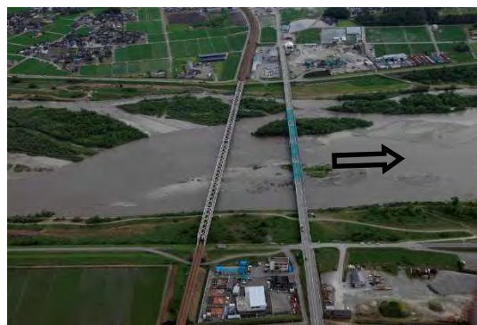
下黒部橋（河口より0.8km）
