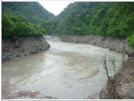
【出し平ダム湛水池】水位低下中(EL.316.10m) 6月17日 9:20撮影
