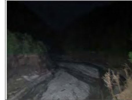
【出し平ダム湛水池】自然流下完了(EL.305.23m) 6月17日 20:04撮影
