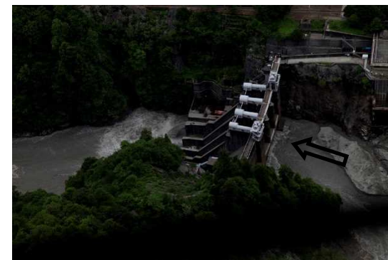
出し平ダム（左岸より望む）
