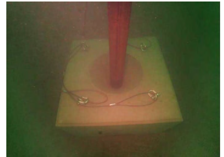
写真-4 湖底でのケーシング固定
